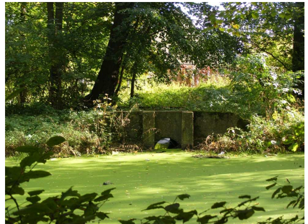
Fot.12 Jaz wypuszczający wodę z fosy.
